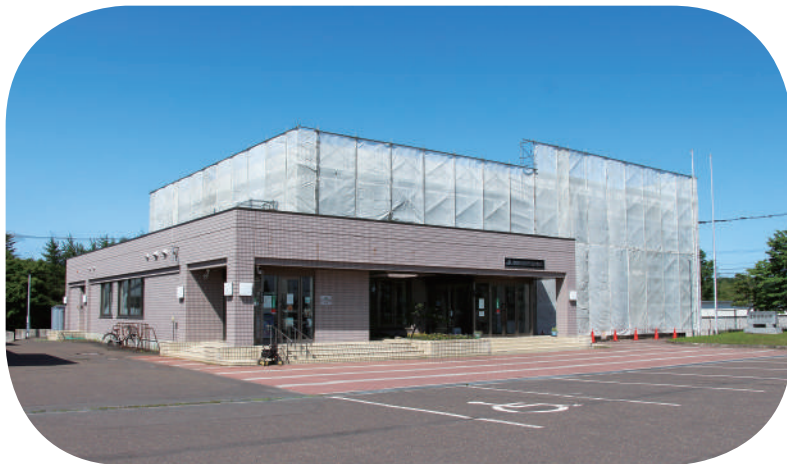
足場に囲われた事務所
