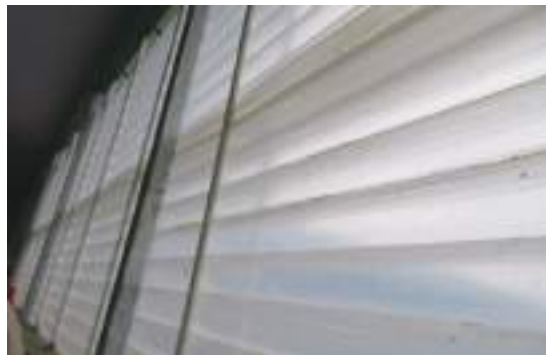
（梁が隠れるような施工で鳥が止まらない様に工夫されている。更に屋根は断熱され、エアーカーテン（右写真）をつけることで冬-30度でもフリーストール内は凍結しない。）
