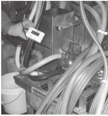
まずは排水温度を確認
