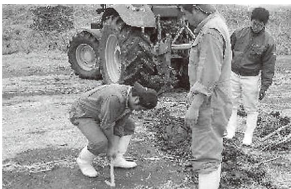
写真3 ピンを刺して施工深確認
