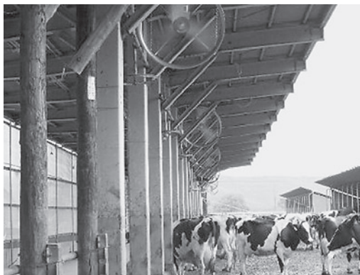
写真3 換気扇の設置
