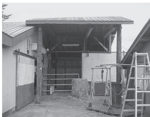
写真2 飼料庫を改造し作製した分娩房
