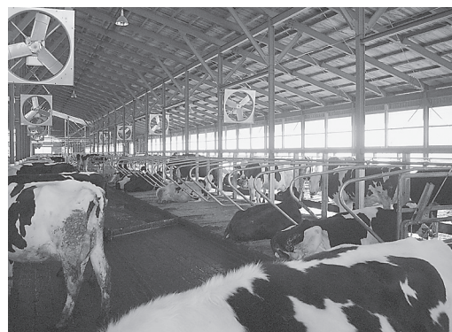
写真2 牛体に風が直接あたるように送風機を設置
