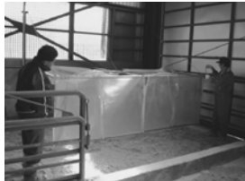
(写真4) フリーバーン牛舎の一部に覆いをつけて日中・夜間の温度差を緩和するための開放換気。
