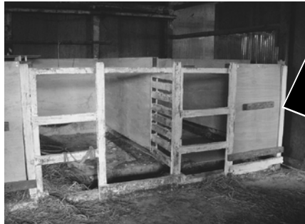
(写真3) 改善後、横壁にコンパネを貼る。上にもコンパネを横向きに乗せる。
