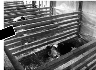
(写真2) 改善前、横の壁が板なので、ペン全体を風が通り抜けてしまう。
