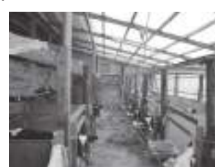
哺育施設建設 (会員農場 2 戸で増設)
