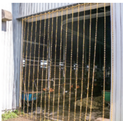
チェーンネットでカラス侵入防止
